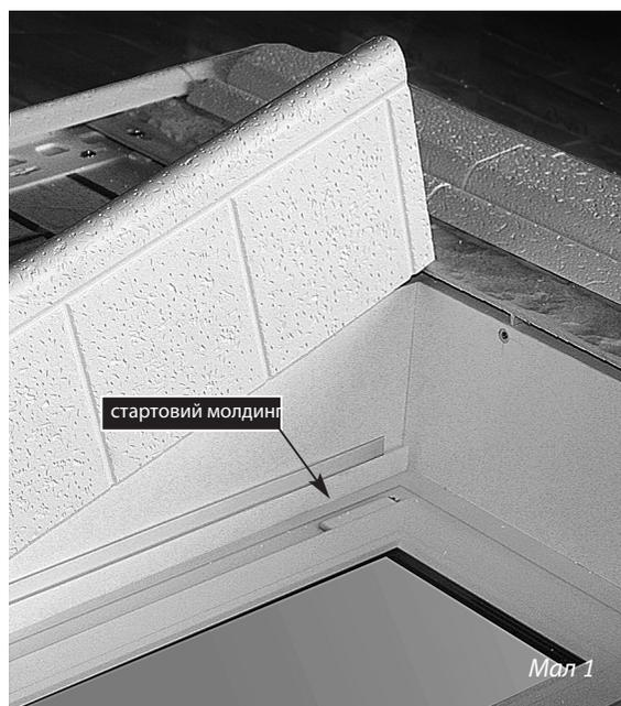
лиштв в кутах віконних або дверних прорізів проводиться шляхом підрізування елементів під кутом 45 °. Запил лиштв здійснюється за допомогою ножівки з дрібними зубцями або,
